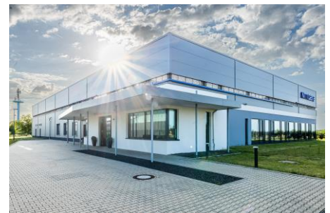
Bautzen Data Center 4 Bautzen, Germany
